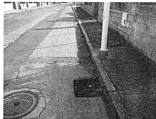
Foto 3 di via Nazionale _ messa in quota Di una caditoia stradale
