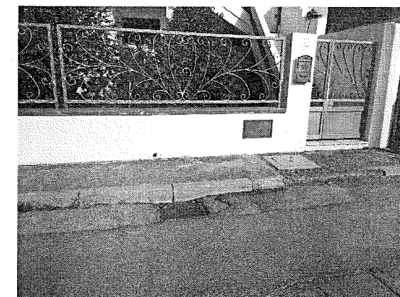
Foto 4 di via Nazionale _ messa in quota Di una caditoia stradale
