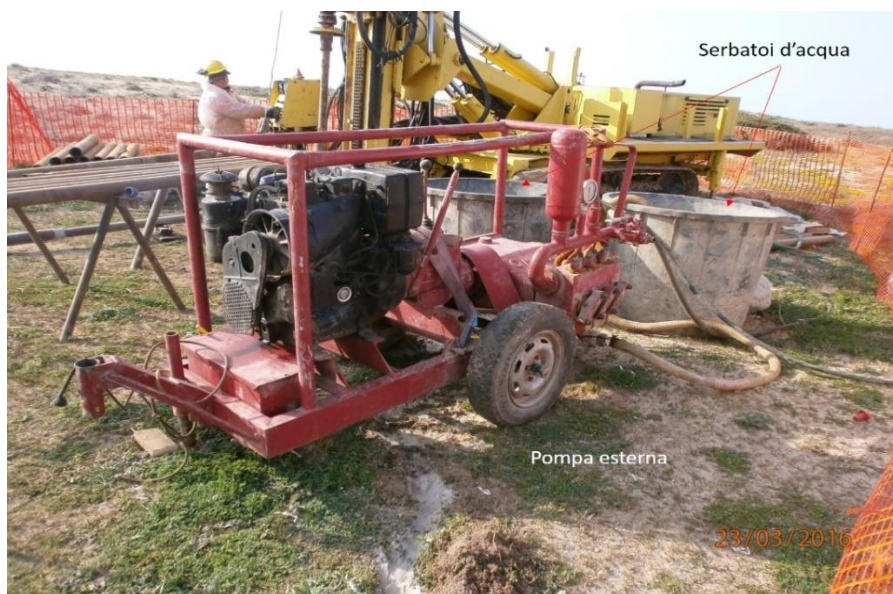
Figura 20 - Pompa e serbatoi dell'acqua a servizio della trivella.
