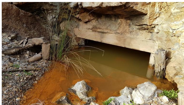
Figura 15 – Sbocco dell'affluente RBI-1 questo punto in passato è stato l'ingresso della galleria per accedere al filone Speranza si può osservare il processo di precipitazione del ferro, ancora più evidente alla confluenza con Rio Melis.
